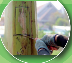
ภาพ 2 ขั้นตอนการเจาะ A.เจาะเป็นรูสี่เหลี่ยม B. ตัดแกนกลางออก
